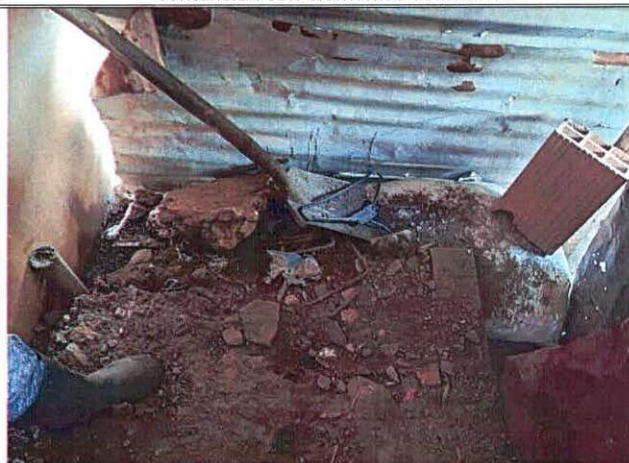
Fotografías 5 y 6. Pérdida de suelo de soporte sobre el que descansan los elementos perimetrales en el costado posterior de la vivienda
