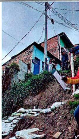
Fotografías 3 y 4. Poste con afectado por movimiento en masa local.
