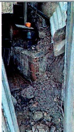
Fotografías 5 y 6. Depósito de material movilizado sobre la cocina de la vivienda evaluada
