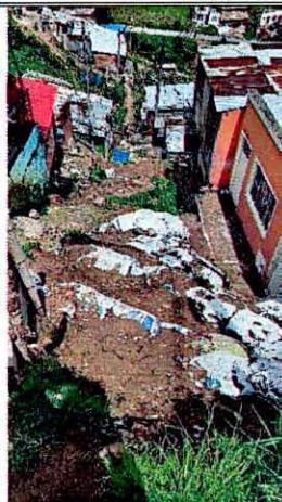
Fotografía 1. Vista General de vía frente a la vivienda de la KR 4A Bis Este No. 59B - 15 Sur
