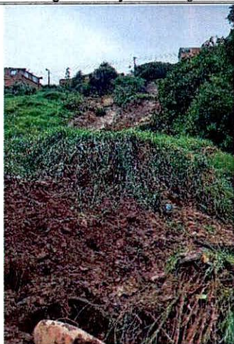
Fotografía 5. Flujos en la parte alta del talud
