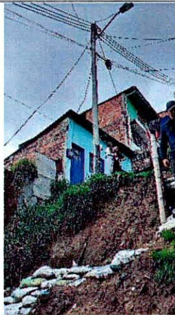
Fotografías 3 y 4. Poste con afectado por movimiento en masa local.
