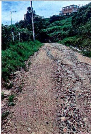
Fotografía 1. Vista General de vía de la Calle 61 Sur entre carrera 4 y 5 Este.
