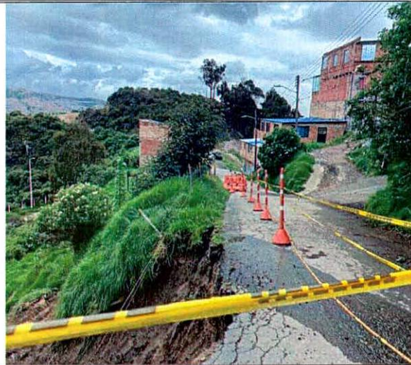
Fotografía 9. Señalización de restricción de carril de la vía de la Calle 60 Sur. Foto tomada 15 mayo 2024
