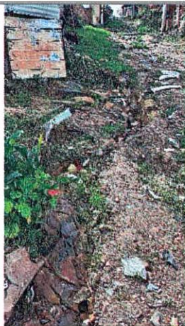
Fotografía 1. Vista General de vía de la Calle 61 Sur entre carrera 4 y 5 Este.
