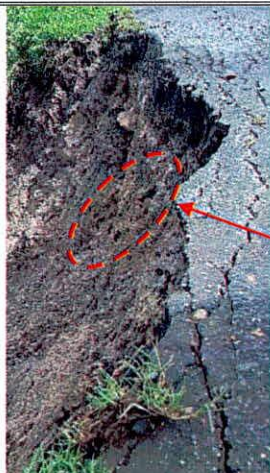
Fotografías 11 y 12. Fractura de tuberías y filtración de agua en el talud de corte
