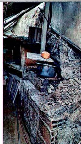
Fotografías 5 y 6. Depósito de material movilizado sobre la cocina de la vivienda evaluada
