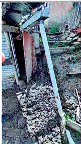
Fotografía 1. Ingreso a la vivienda de la KR 4C Este No. 59B – 05 Sur
