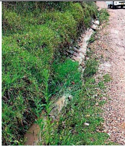
Fotografía 6. Presencia de agua acaudalada en la cuneta perimetral de la vía de la Calle 61 Sur
