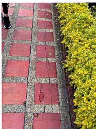
Fotografías 11 y 12. Fisuras en acabados de piso zonas comunes predio inspeccionado.
