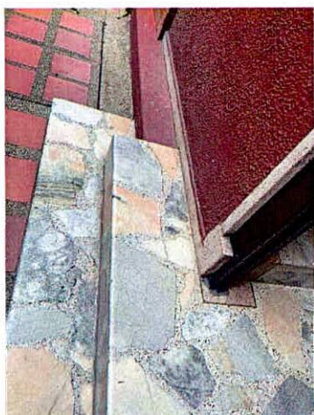
Fotografías 13 y 14. Fisuras en acabados de piso zonas comunes predio inspeccionado.
