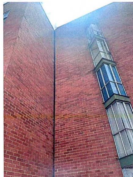
Fotografías 7 y 8. Dilataciones entre torres localizadas al costado nororiental del predio evaluado.
