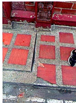
Fotografías 11 y 12. Fisuras en acabados de piso zonas comunes predio inspeccionado.
