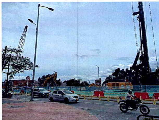
Fotografía 23. Obras de intervención en la sobre la vía vehicular de la Transversal 31 "Avenida Ciudad de Quito" a la altura de la Calle 17 Sur
