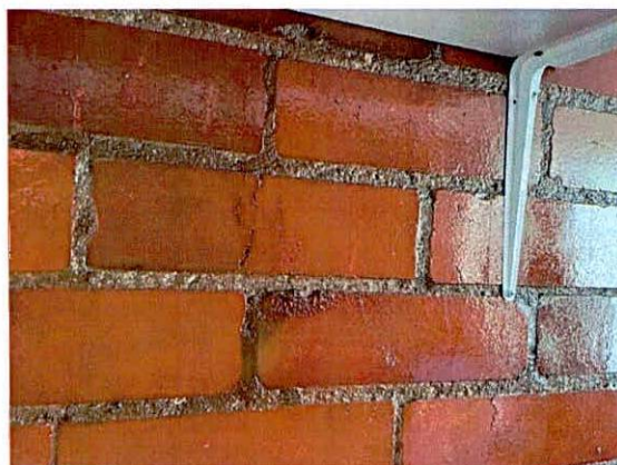
Fotografías 19 y 20. Levantamiento de acabados de pisos y en fisuras de muro interior apartamento 419 interior 10
