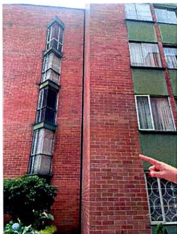
Fotografía 9. Dilataciones entre torres localizadas al costado nororiental del predio evaluado.
