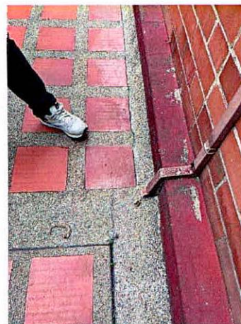
Fotografías 13 y 14. Fisuras en acabados de piso zonas comunes predio inspeccionado.
