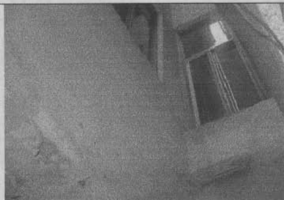
Foto 5. Muros de la fachada interior pañetados.
