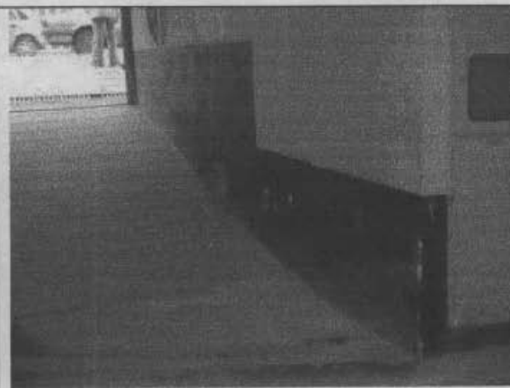
Foto 4. Acceso a semisótano.
