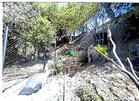
Fotografía 6. Muestra de obras (cunetas y cerramiento) desarrolladas en costado oriental de la huerta. Tomada el 26/01/2024
