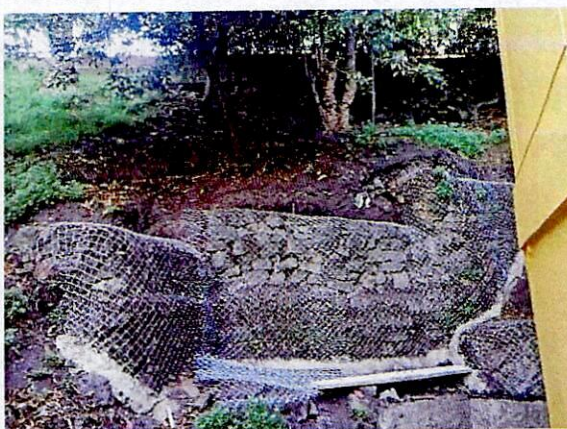
Fotografía 3. Muestra del estado de gaviones en acceso a huerta. Tomada del DI-19601 (04/10/2023)
