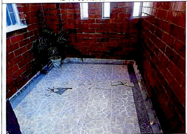
Fotografía 3. Vista de la zona del patio hacia el costado occidental del apartamento 149 del Interior 14.
