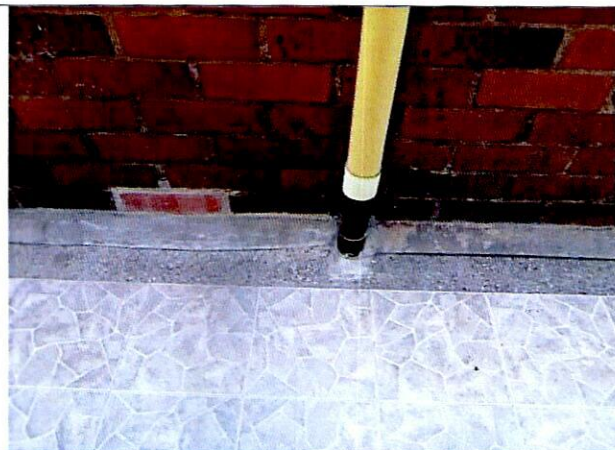
Fotografía 5. Bajante de aguas lluvias ubicado en la zona del patio del apartamento 149 del Interior 14.
