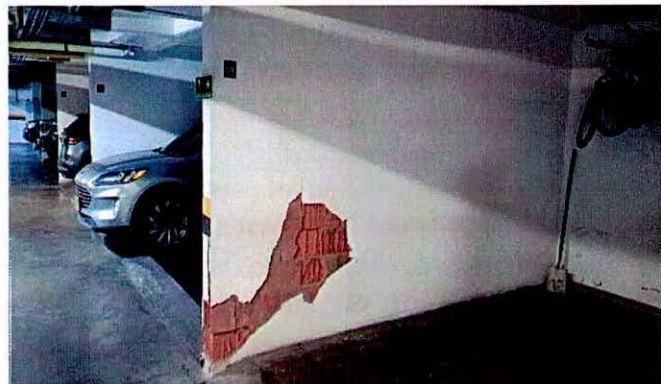
Fotografía 2. Vista general del muro por el costado norte garaje 88
