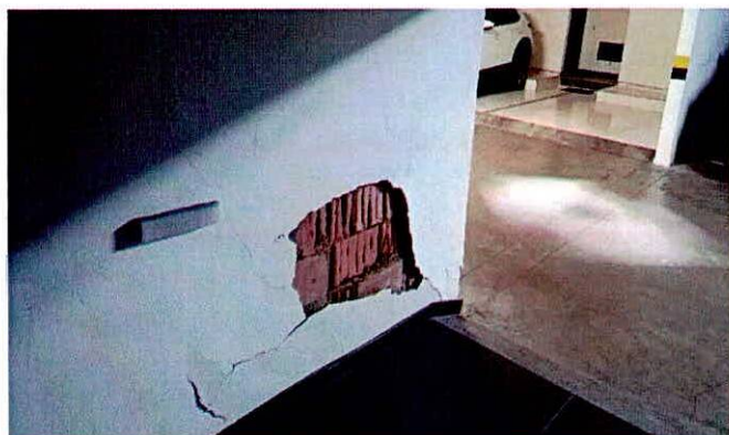
Fotografía 3. Vista general del muro por el costado sur garaje 87
