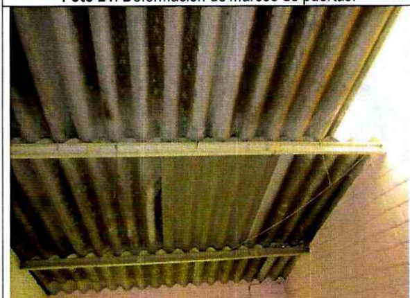
Foto 23. Elementos de cubierta en buenas condiciones.
