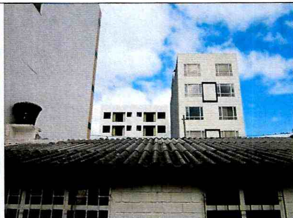
Foto 22. Cubierta en buen estado, daño leve.
