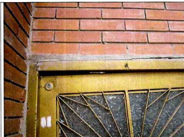
Foto 21. Deformación de marcos de puertas.
