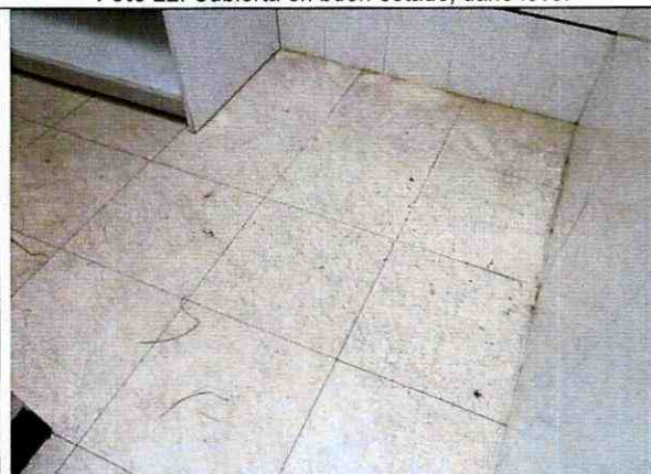
Foto 24. Sector de placa de piso sin daño visible.
