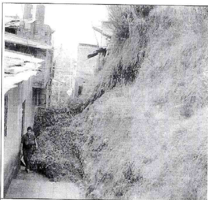
Fotografía 1. Vista de la zona deslizada
