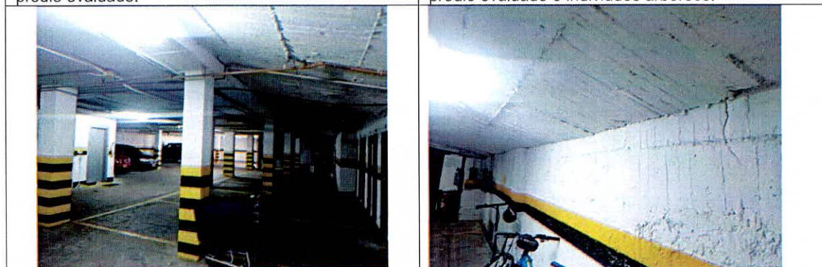
Fotografía 7. Interior del sótano de parqueaderos del edificio Paula Jimena.
