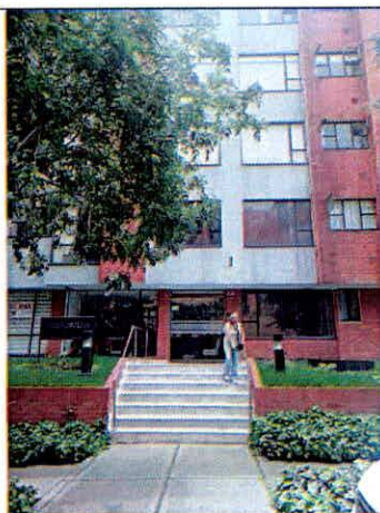
Fotografía 1. Fachada principal de la edificación evaluada
