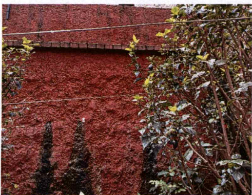
Fotografías 5 y 6. Manchas de humedad, y suciedad en muro de contención costado oriental predio evaluado.
