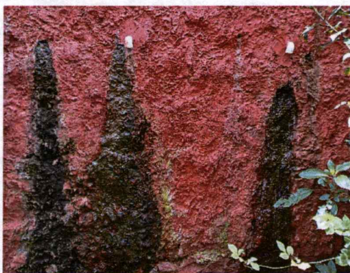
Fotografías 5 y 6. Manchas de humedad, y suciedad en muro de contención costado oriental predio evaluado.
