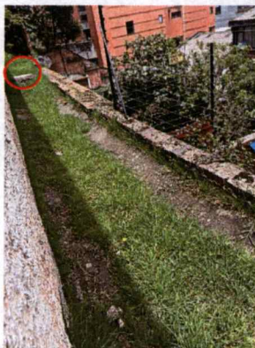
Fotografía 7. Parte alta predio evaluado donde se localiza una alcantarilla.
