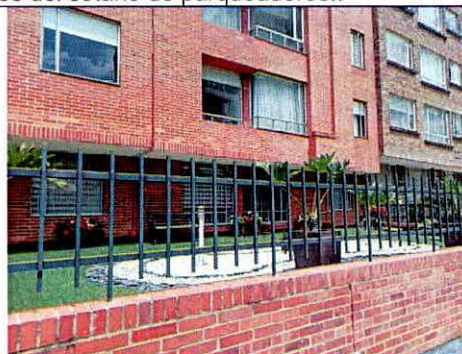
Fotografía 8. Jardineras localizadas en el costado norte de la edificación evaluada
