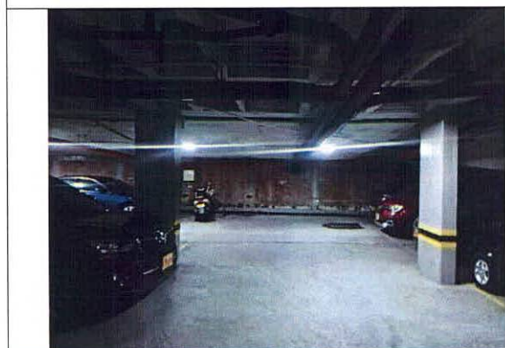
Fotografía 3. Condiciones generales del sótano de parqueaderos del predio evaluado.
