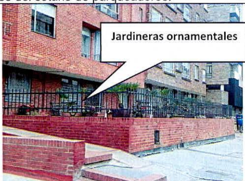
Fotografía 7. Jardineras localizadas en el costado norte de la edificación evaluada
