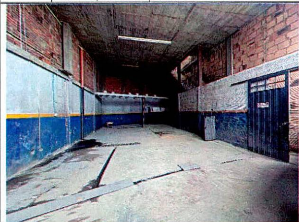
Fotografía No. 6. Vista al interior de la edificación del predio P2, donde no se observan afectaciones.
