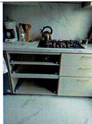
Fotografía 14. Zona de cocina donde se realizaba la remodelación en el apartamento 1001.
