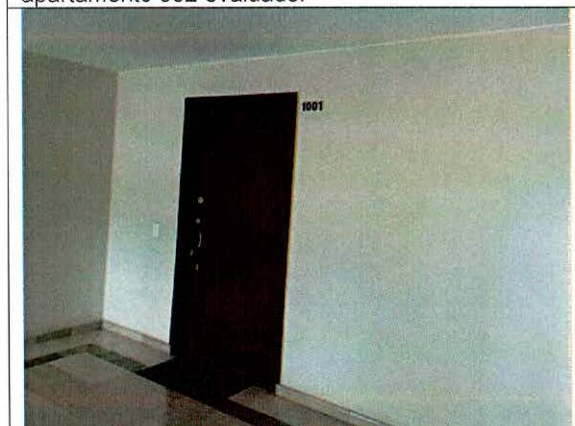
Fotografía 11. Acceso principal del apartamento 1001 de la edificación evaluada.
