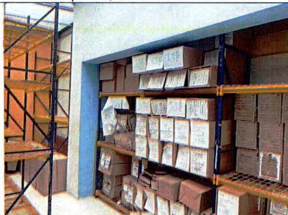
Fotografía 6. Depósito donde se presentó la conflagración en 2018, actualmente reparado y en funcionamiento.
