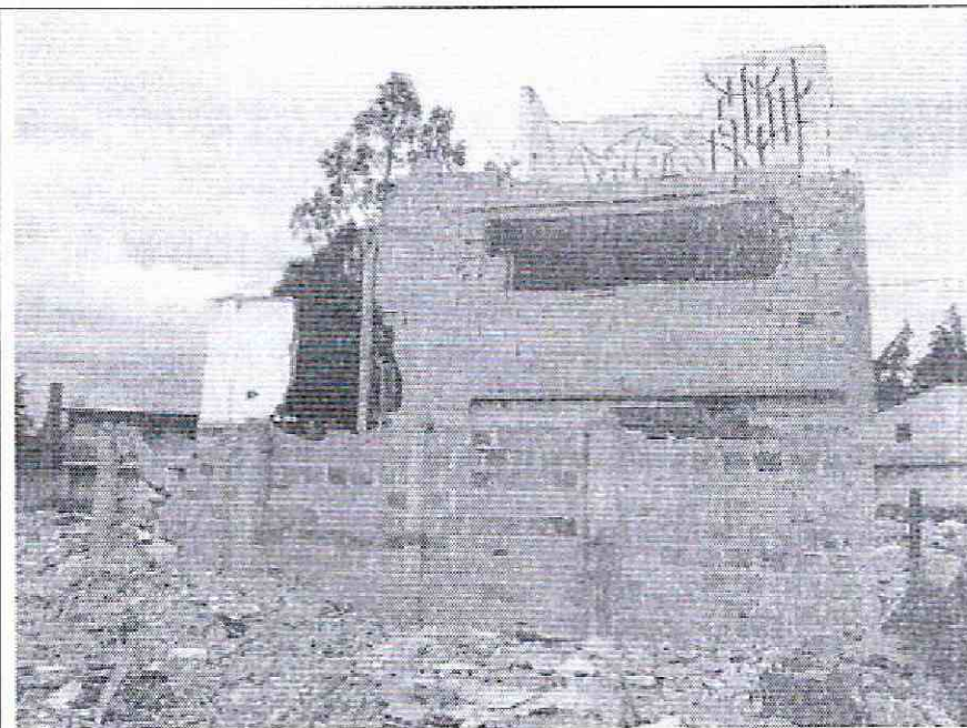
Foto 4. Demolición parcial de muros.
