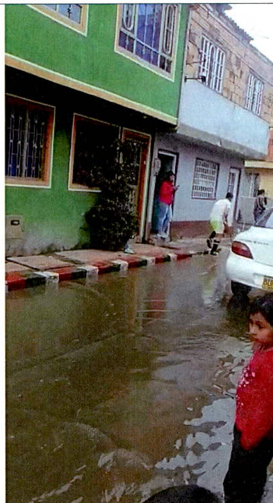
Fotografía 5. Encharcamientos de agua en el polígono evaluado (fotografía suministrada por la comunidad)
