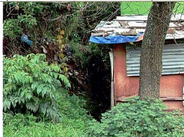
Fotografía 6. Movimiento en masa local del talud y ladera ubicada al costado sur del predio P2.
