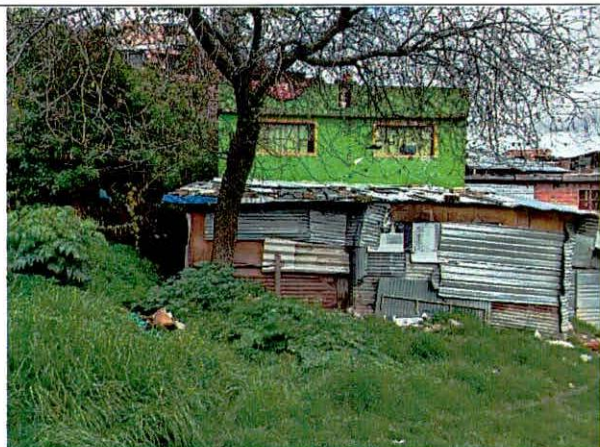
Fotografía 6. Vista general del predio P2: KR 11 ESTE 28C 70 SUR.
