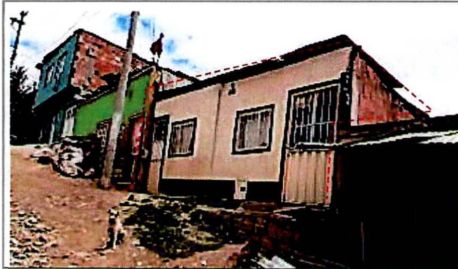
Fotografía 8. Fachada predio P2
