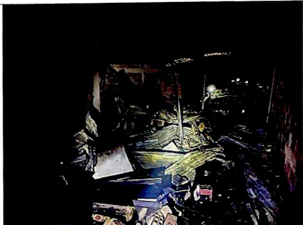
Fotografía 7. Pérdida total de estructura en material de recuperación en el costado posterior de V1
