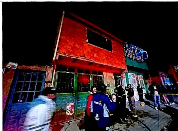
Fotografía 2. Fachada de la vivienda V1
