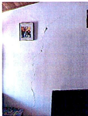
Fotografías 3 y 4. Daños observados en la unidad habitacional P1A emplazada en el predio P1.
