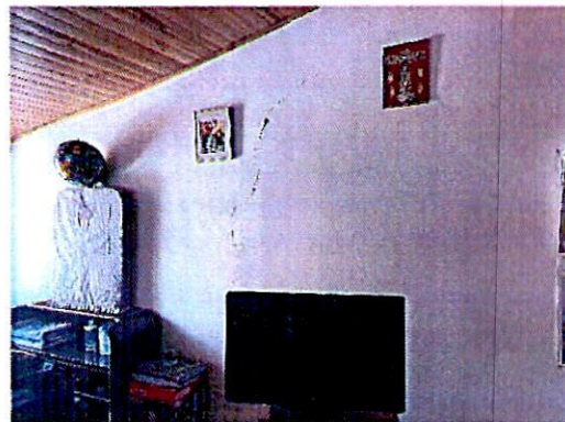
Fotografías 3 y 4. Daños observados en la unidad habitacional P1A emplazada en el predio P1.
