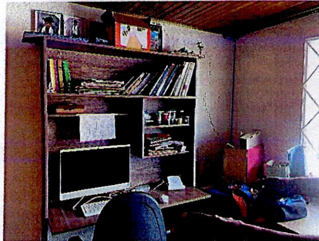
Fotografía 8. Daños observados en la unidad habitacional P2B emplazada en el predio P2.
