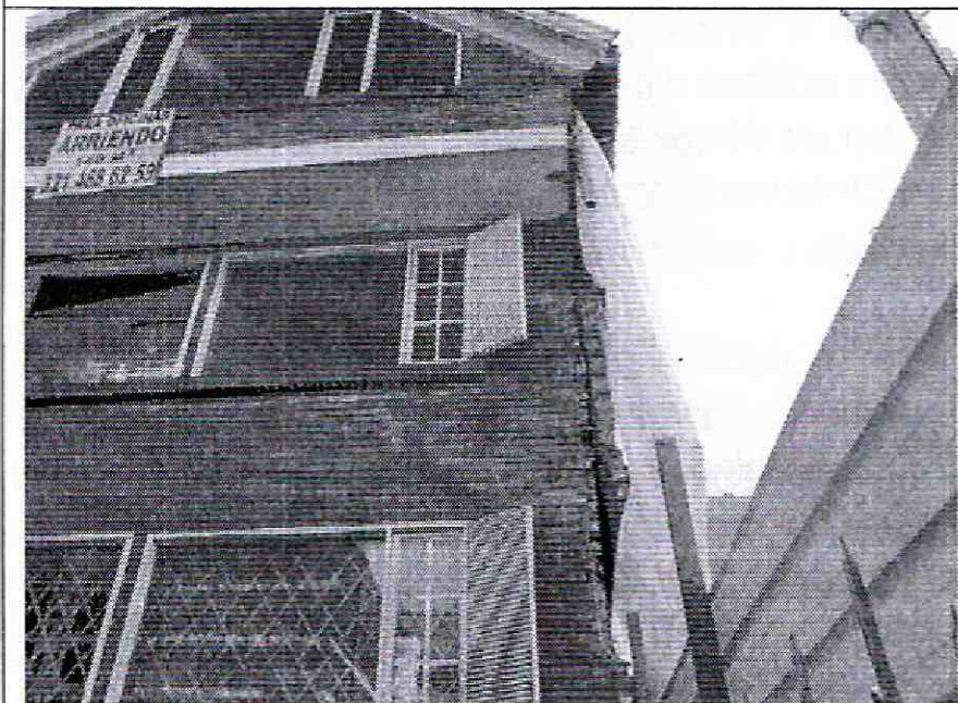
Foto 3. Extremo occidental del muro de fachada.
