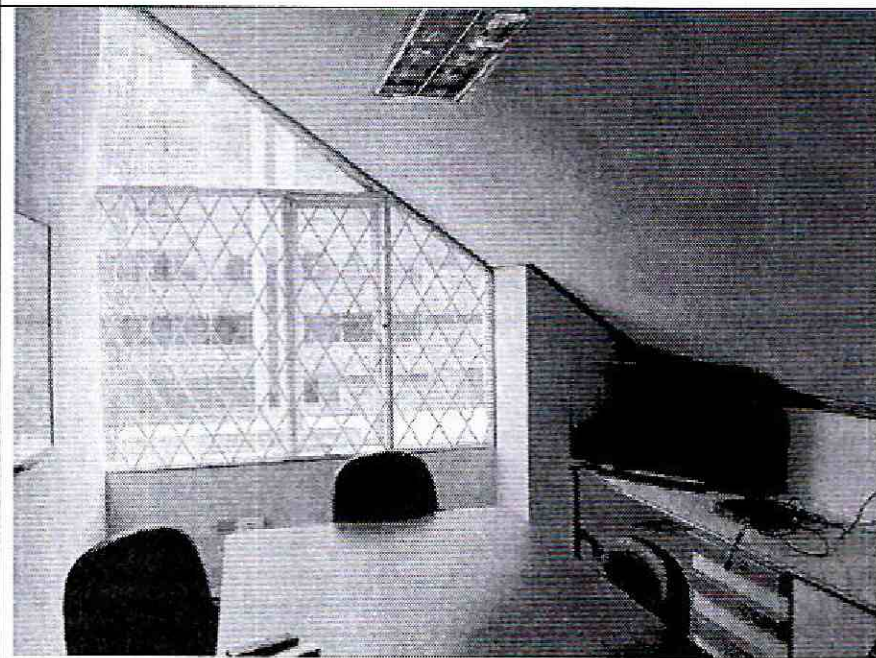
Foto 27. Cielo raso bajo cubierta sin evidencia de daños.
