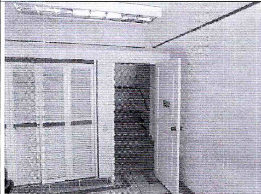
Foto 15. Buen estado de elementos de niveles superiores.
