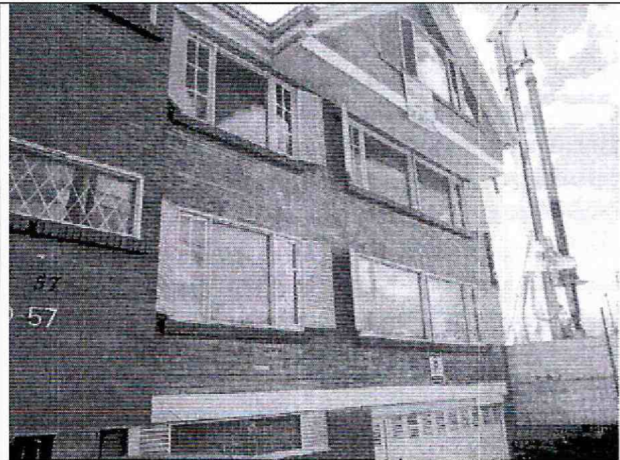
Foto 2. Muros de fachada en buenas condiciones.
