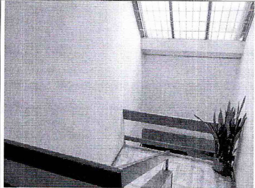
Foto 26. Escaleras y puntos fijos sin daños visibles.
