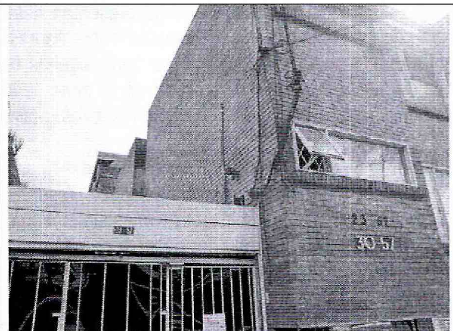
Foto 4. No se detectan afectaciones en muro de fachada.
