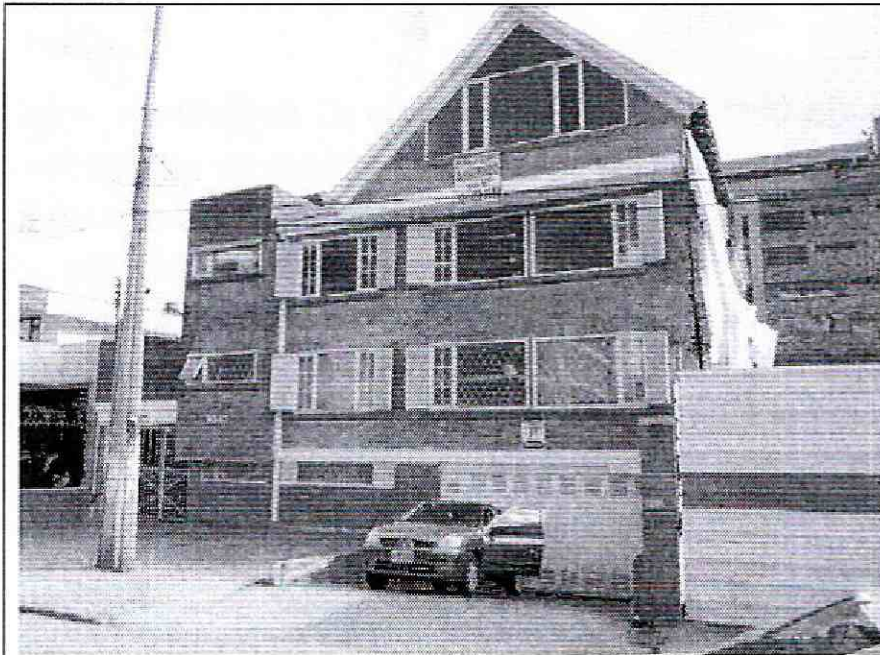
Foto 1. Vista general del exterior del inmueble visitado.
