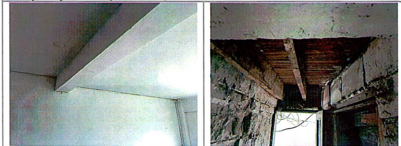
Fotos 3 y 4. Entrepiso de la vivienda en concreto y madera. Evidencia de la incorporación de algunas vigas a la construcción
