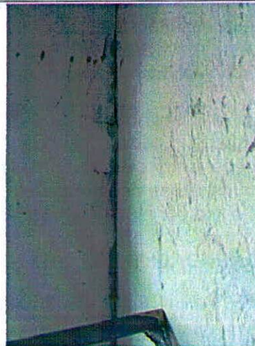
Foto 8. Dilataciones entre muros.
