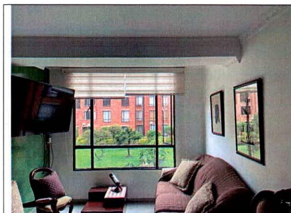
Fotografía 5. Otros sectores del apto 201, sin evidencia de goteras.
