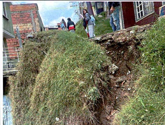
Fotos 3 y 4. Sector donde se presentó el desprendimiento de material, evidencia del material con posibilidad de caída
