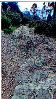
Fotografías 3 y 4. Ausencia de estructura de pavimento y marcación natural de los drenajes de escorrentía del sector.
