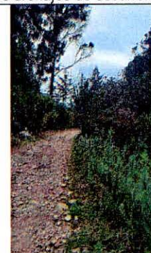
Fotografías 5 y 6. Ausencia de estructura de pavimento y sistemas de drenaje de agua superficial y subsuperficial de la vía.
