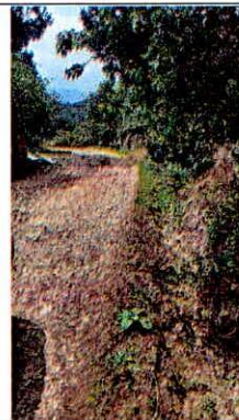
Fotografías 3 y 4. Ausencia de estructura de pavimento y marcación natural de los drenajes de escorrentía del sector.
