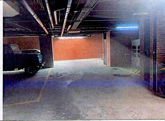
Fotografía 4. Zona de parqueadero en el primer nivel. Sin daños sobre placa de contrapiso.
