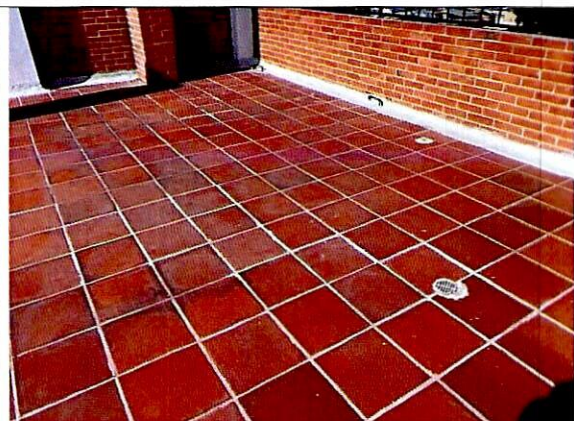
Fotografía 8. Reemplazo de baldosas e instalación de sifones. Sin evidencia de daños.
