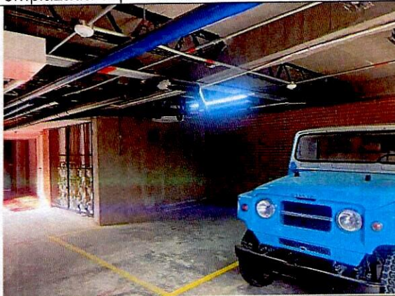
Fotografía 3. Zona de parqueadero en el primer nivel. Sin daños sobre muros.
