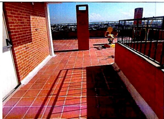
Fotografía 6. Terraza. Sin evidencia de daños ni encharcamientos.
