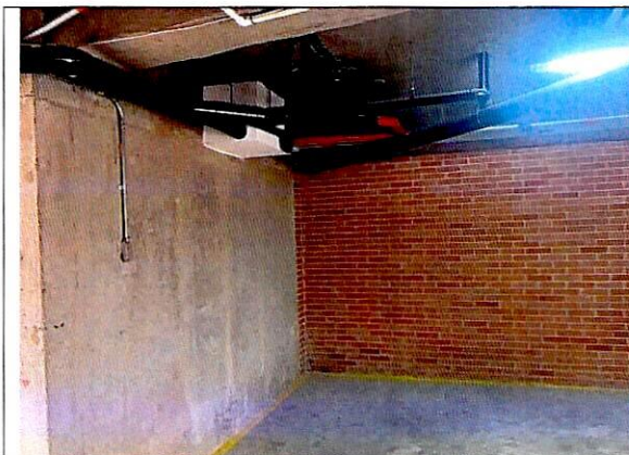
Fotografía 5. Zona de parqueadero en el primer nivel. Sin daños sobre muros. Zona al parecer intervenido por el Constructor.
