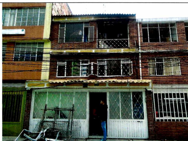
Fotografía 2. Vista frontal del predio evaluado
