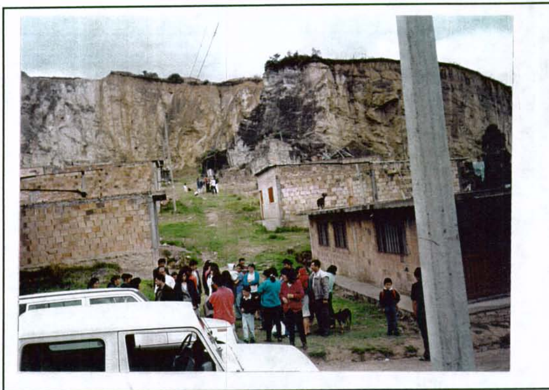
Tipo de edificaciones ubicadas en inmediaciones de talud.
