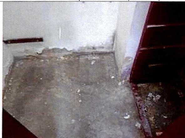
Foto 6. Humedades en pisos del Apto. 144.
