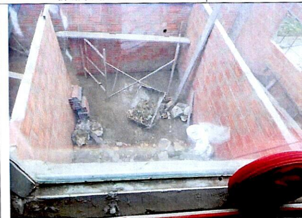
Fotografía 9. Vista desde el predio P3 a la obra que se lleva a cabo en el predio P2.
