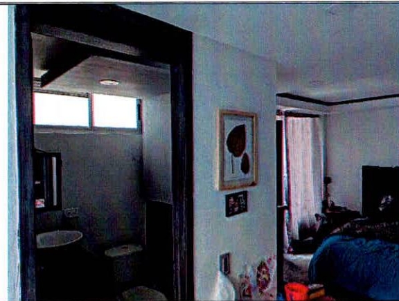
Fotografía No. 4. Vista del interior de la vivienda evaluada donde no se observan daño estructurales.
