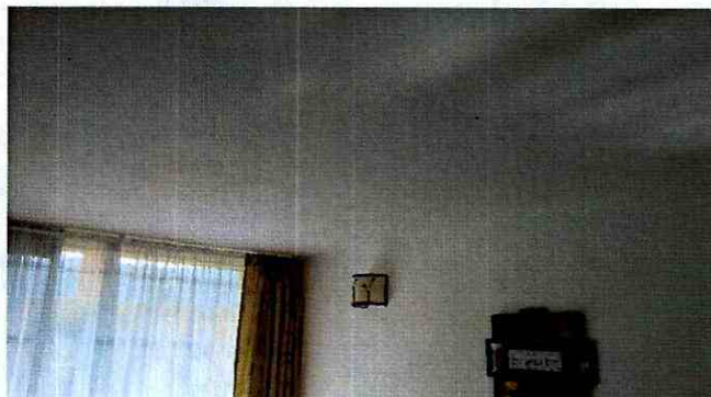
Fotografía 9. En la placa superior del apartamento 1202 donde se ubica la modificación, no se presentan deflexiones perceptibles a la vista ni fisuras.
