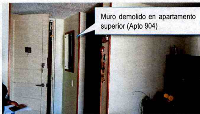
Fotografía 12. Demolición del muro estructural ubicado en el apartamento 904. Foto tomada en el interior del apartamento 804
