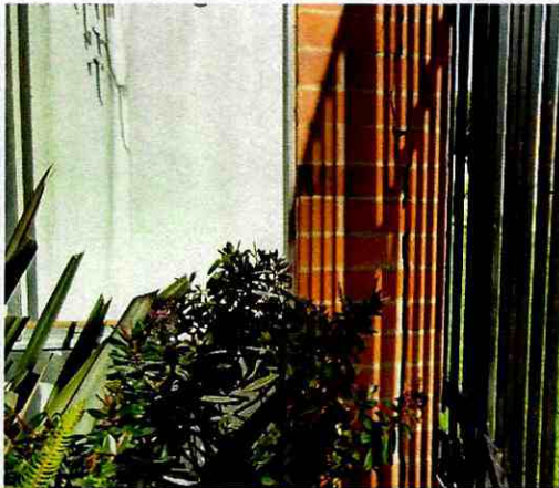
Fotografías 5 y 6. Grieta vertical en la unión de la mampostería de la fachada del primero piso de la torre 7
