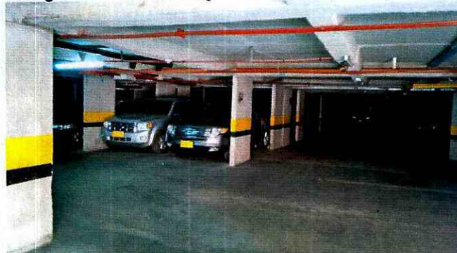
Fotografía 3. Sistema estructural de muros de concreto reforzado. No se identifican asentamientos excesivos en la zona del sótano. Se evidencia un buen comportamiento de los elementos estructurales que conforman el sótano.
