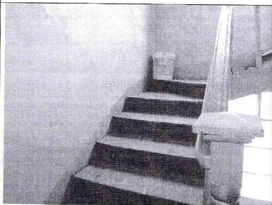
Foto 36. Escaleras a cuarto piso sin afectaciones.
