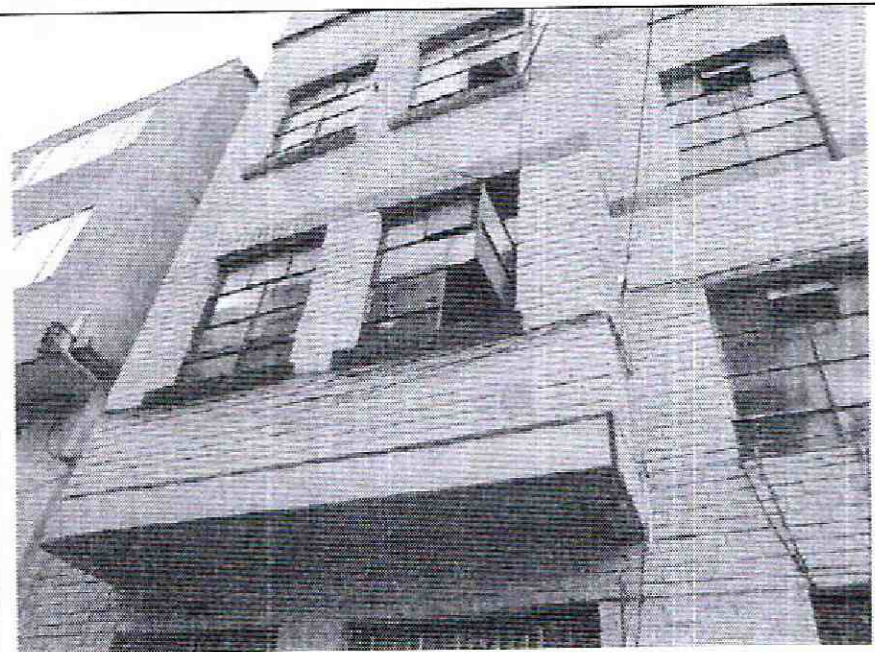
Foto 2. Muro de fachada sin daños visibles.
