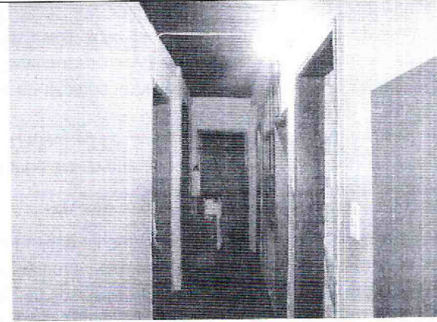
Foto 6. Aspecto general de muros del segundo piso.
