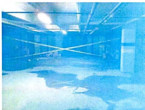
Fotografías 6 y 7. Filtraciones y empozamiento de agua a nivel de sótanos en el predio evaluado.
