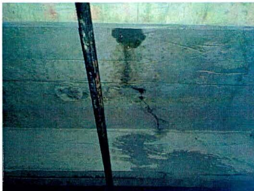
Fotografías 10 y 11. Filtraciones en muros perimetrales nivel de sótanos en el predio evaluado.
