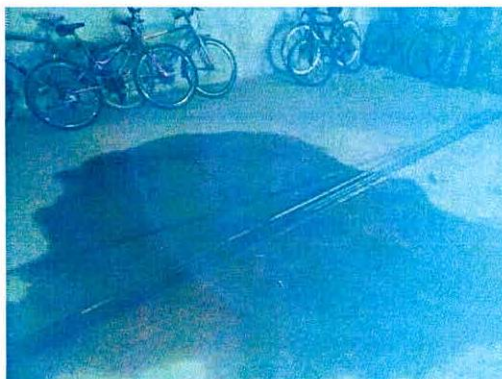
Fotografías 4 y 5. Filtraciones y empozamiento de agua a nivel de sótanos en el predio evaluado.
