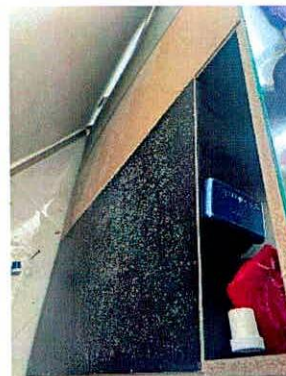
Fotografías 25 y 26. Manchas de humedad y presencia de hongos apartamentos 201 y 804 torre 2.
