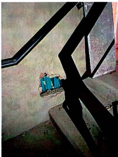
Fotografías 21 y 22. Exposición de redes eléctricas en el predio evaluado.
