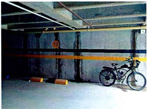
Fotografías 10 y 11. Filtraciones en muros perimetrales nivel de sótanos en el predio evaluado.
