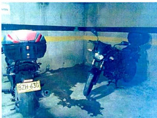
Fotografías 4 y 5. Filtraciones y empozamiento de agua a nivel de sótanos en el predio evaluado.
