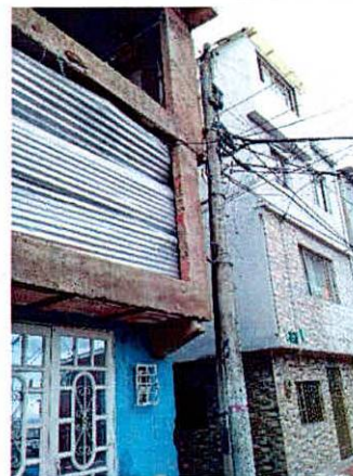
Fotografía 18. Poste de luz localizado al costado norte del predio P1.
