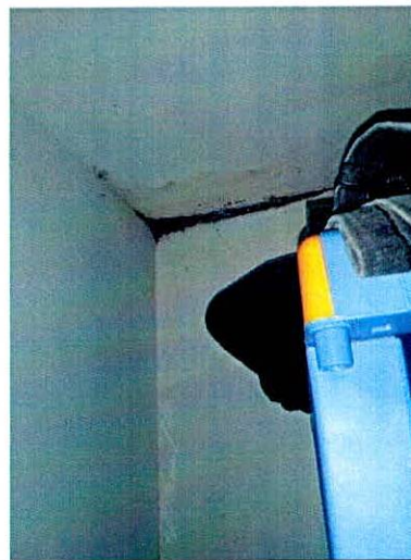
Fotografías 21 y 22. Manchas de humedad en muros perimetrales e divisorios predio P2.
