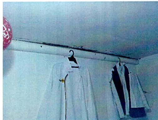
Fotografías 23 y 24. Manchas de humedad en muros perimetrales e divisorios predio P2.
