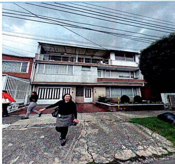
Fotografía 1. Vivienda ubicada en la Cra 63 # 67 A -55.
