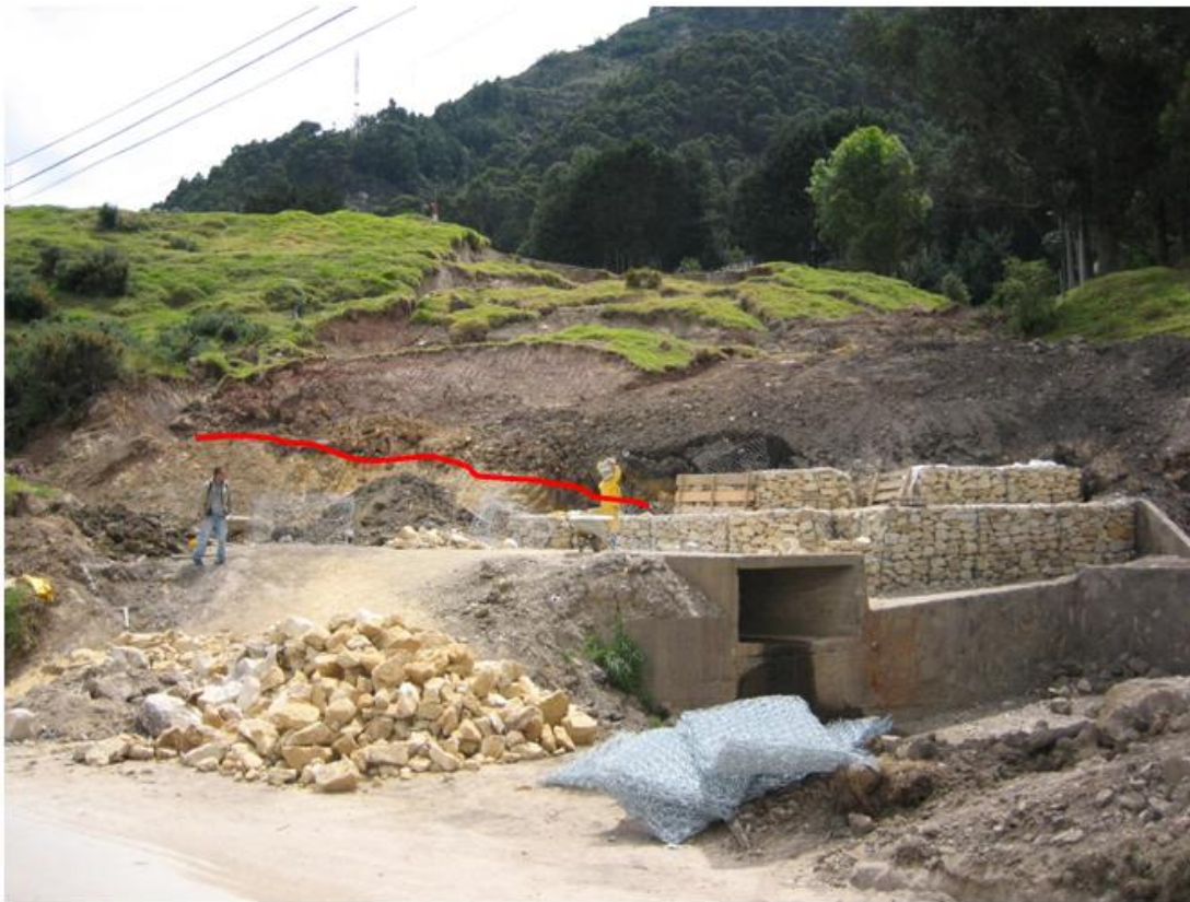
Figura 4. 47 Plano de falla sobre la roca.
