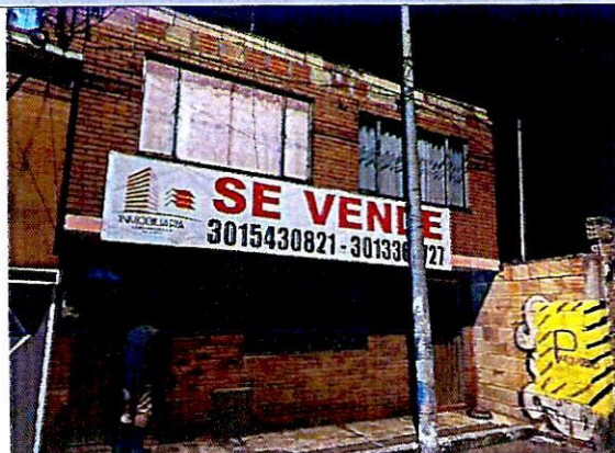
Fotografía 29. Vivienda emplazada en el predio P8, dos niveles, construida en mampostería parcialmente confinada.
