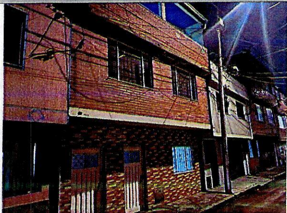
Fotografía 21. Vivienda emplazada en P6, dos niveles y terraza, construida en mampostería parcialmente confinada.
