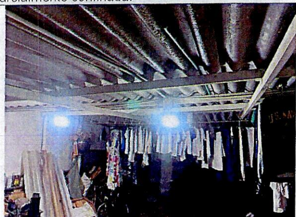
Fotografía 11. Terraza de P3, tejas de fibrocemento apoyadas sobre estructura metálica apoyada sobre los muros del último nivel.
