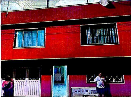
Fotografía 13. Vivienda emplazada en P4, dos niveles y terraza, construida en mampostería parcialmente confinada.
