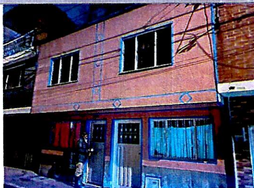
Fotografía 25. Vivienda emplazada en el predio P7, dos niveles, construida en mampostería parcialmente confinada.
