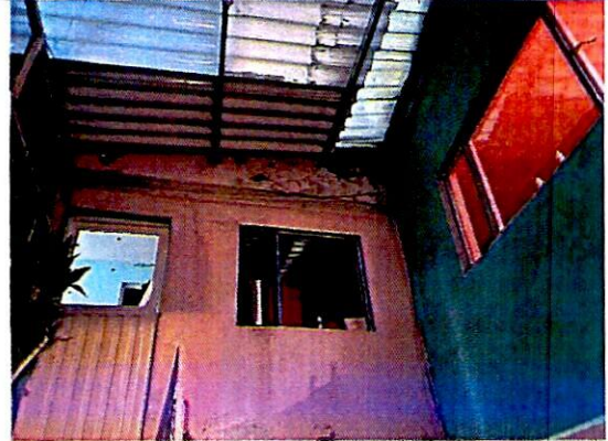
Fotografía 14. Vista al interior de la vivienda de P4, sin evidencia de daños sobre muros.
