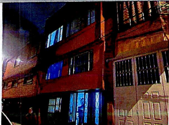
Fotografía 9. Vivienda emplazada en el predio P3, tres niveles y una terraza, construida en mampostería parcialmente confinada.
