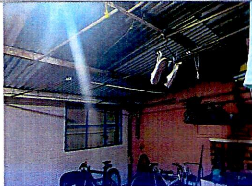
Fotografía 26. Vista al interior de la vivienda de P7, sin evidencia de daños sobre la cubierta, conformada por tejas de zinc soportadas por estructura en madera.
