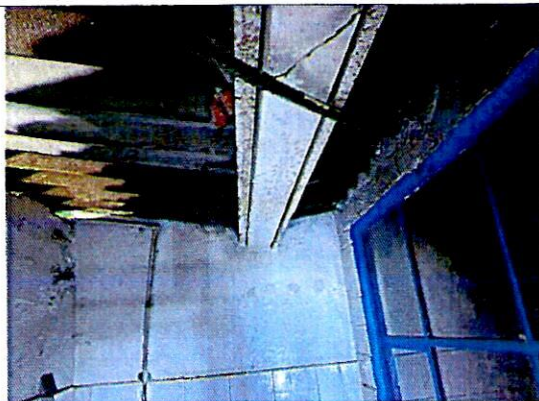
Fotografía 27. Vista al interior de la vivienda de P7, sin evidencia de daños sobre las canales para recolección y evacuación de aguas lluvias.
