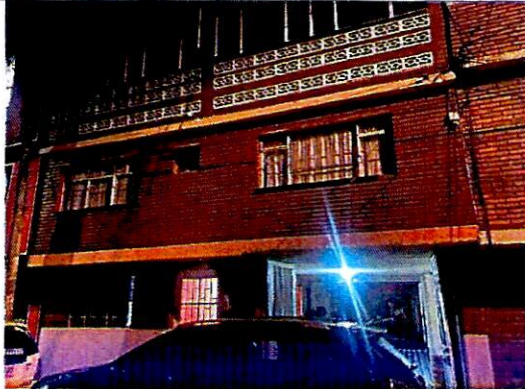
Fotografía 1. Vivienda emplazada en P1. Tres niveles, construida en mampostería parcialmente confinada.
