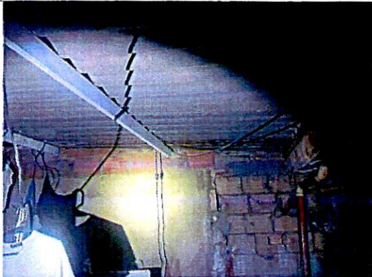
Fotografía 3. Habitación del tercer nivel, estructura que soporta la cubierta sin evidencia de daños.
