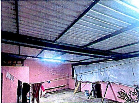
Fotografía 15. Terraza de P4, sin evidencia de daños sobre la estructura metálica ni sobre las tejas.
