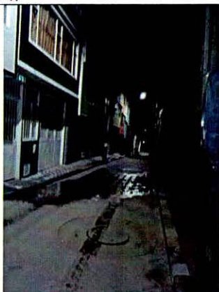
Fotografía 4. Aguas servidas provenientes del interior de los predios inspeccionados P1 y P2.
