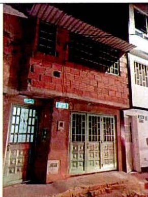
Fotografía 2. Identificación de la edificación que se localiza en el predio P1.
