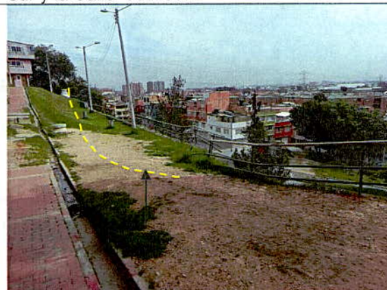
Fotografía 4. Grieta de tracción identificada en el DI-15959.
