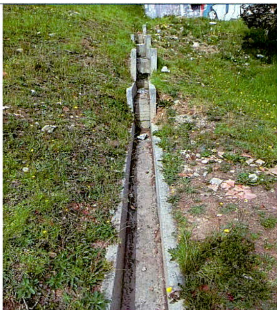
Fotografía 12. Estructuras de disipación de flujo implementadas hacia el sector de la Carrera 43B
