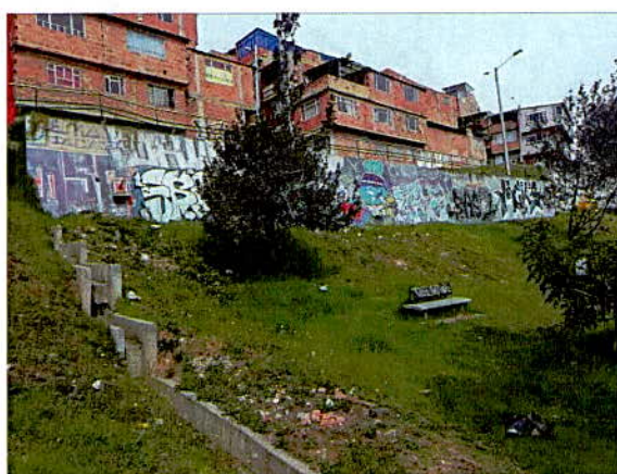
Fotografía 1. Muro de contención implementado en la ladera de la Diagonal 68A Sur y la Calle 68B Sur.
