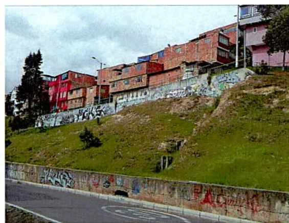
Fotografía 2. Muro de contención implementado en la ladera de la Diagonal 68A Sur y la Calle 68B Sur.
