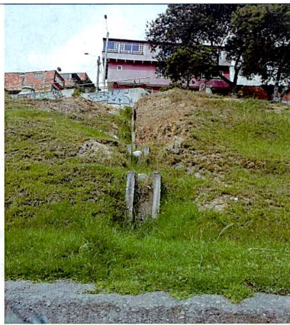
Fotografía 12. Estructuras de disipación de flujo implementadas hacia el sector de la Carrera 44.
