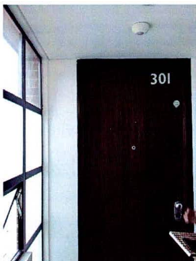
Fotografía 9. Apartamento 301 localizado en el predio evaluado.
