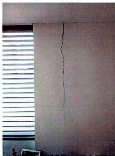
Fotografías 5 y 6. Fisuras identificadas en el apartamento 203 localizado en el predio evaluado.
