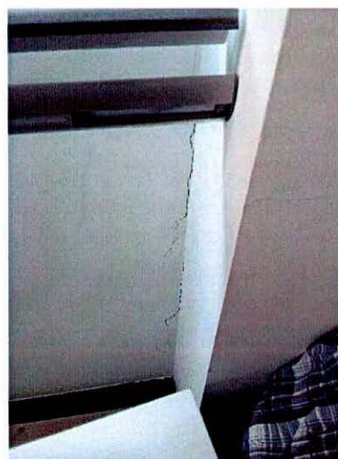
Fotografías 7 y 8. Fisuras identificadas en el apartamento 203 localizado en el predio evaluado.
