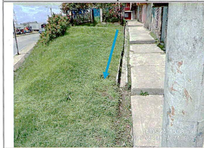
Fotos 5 y 6. Vista de las canales localizadas a la parte alta del talud, que vierten el agua directamente al sector afectado.
