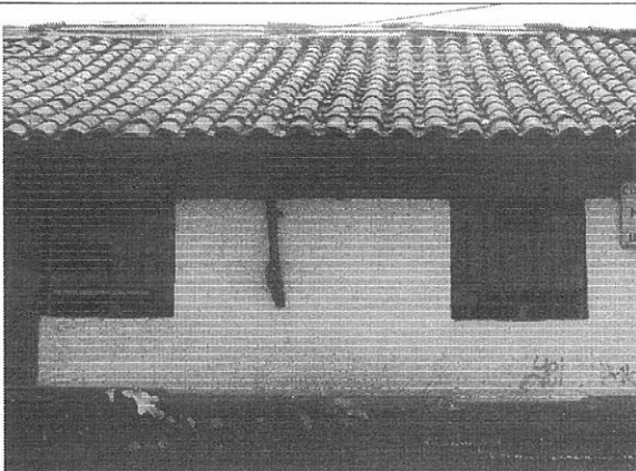
Foto 2. Muro de fachada y cubierta en buen estado.
