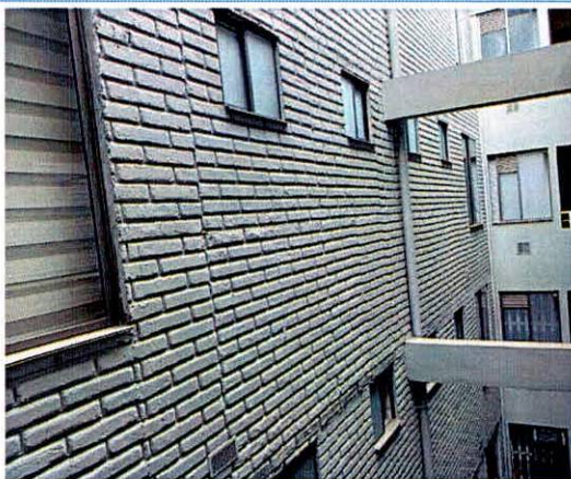
Foto 7. Fachada interna del Interior 3
