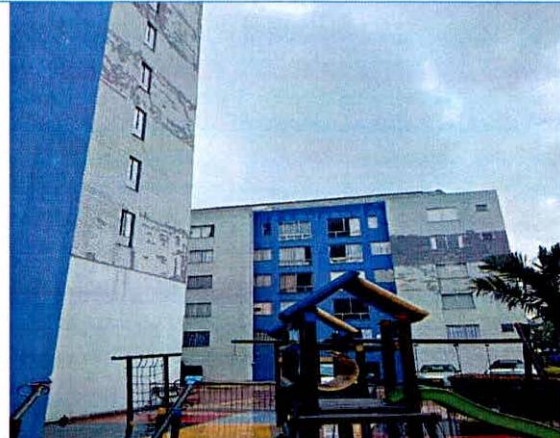
Foto 8. Vista fachadas externas de torres
