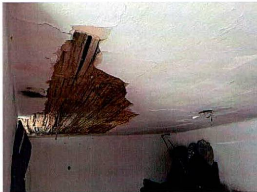
Fotografías 11 y 12. Desprendimiento de la esterilla de guadua en la habitación No.1 (segundo nivel) del predio P1. (Fotografía tomada Del 22 de mayo de 2024)
