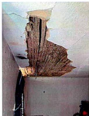
Fotografías 11 y 12. Desprendimiento de la esterilla de guadua en la habitación No.1 (segundo nivel) del predio P1. (Fotografía tomada Del 22 de mayo de 2024)
