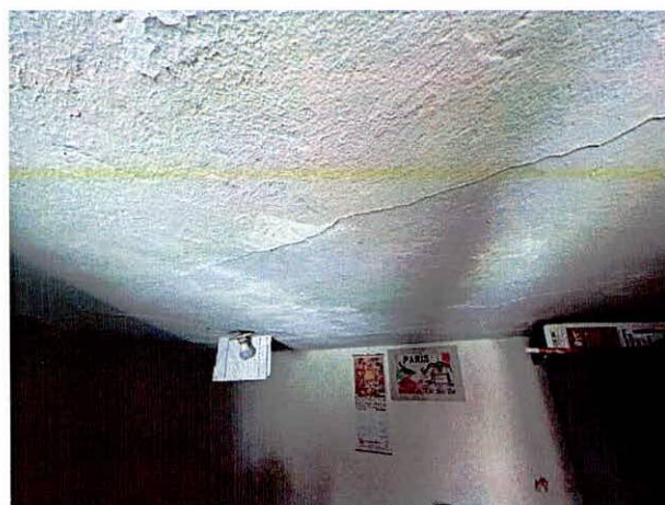
Fotografías 9 y 10. Desprendimiento de la esterilla de guadua en la habitación No.1 (segundo nivel) del predio P1. (Fotografía tomada del diagnóstico técnico DI-18293)
