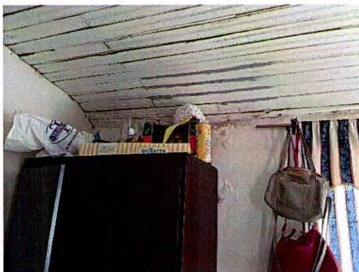
Fotografías 13 y 14. Desprendimiento de la esterilla de guadua en la habitación No.1 (segundo nivel) del predio P1. (Fotografía tomada Del 22 de mayo de 2024)
