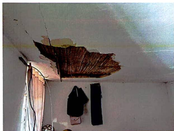
Fotografías 9 y 10. Desprendimiento de la esterilla de guadua en la habitación No.1 (segundo nivel) del predio P1. (Fotografía tomada del diagnóstico técnico DI-18293)
