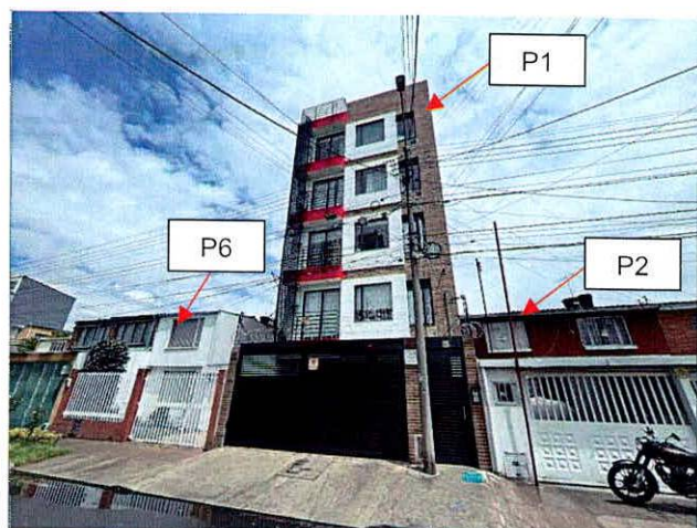
Fotografía 1. Fachada del predio P1
