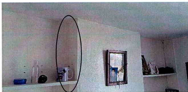
Fotografía 3. Vista dilatación entre muros.
