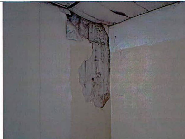
Fotografía 4. Desprendimiento de pintura en muro perimetral del predio
