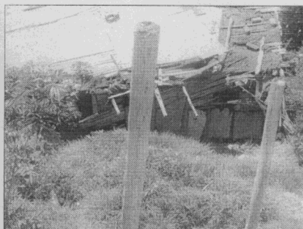
Fotografía 6. Deslizamiento que está empujando la vivienda del señor Isidro Mogollón.
