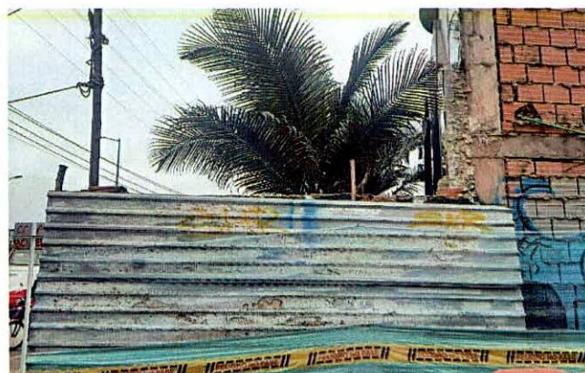
Fotografía 8. Cerramiento provisional instalado al muro del costado norte.
