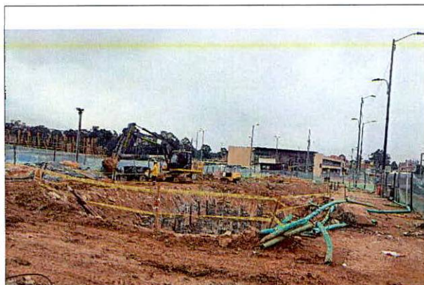
Fotografía 1. Vista General de la obra que se adelanta en el sector
