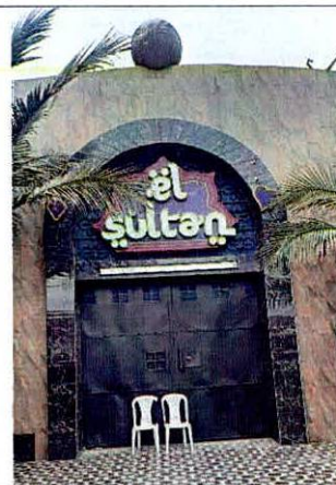
Fotografía 2. Fachada de la edificación evaluada.
