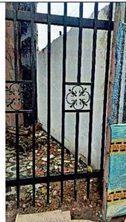
Fotografía 4. Cerramiento de la zona del aislamiento del frente en la edificación evaluada.
